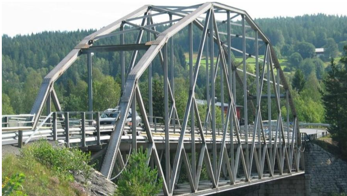
Arbeidet med å erstatte Grettefoss bru i Svene er i gang. Hvor ellers i fylket er det behov for tiltak på veiene
